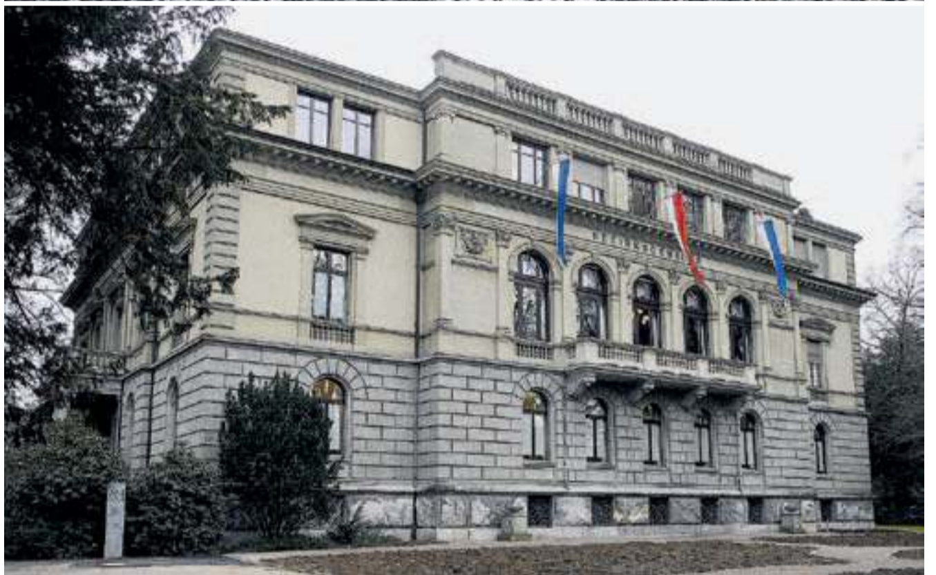
Das Gerichtsgebäude war einst selbst Schauplatz eines Wirtschaftskrimis, damals noch mit einem Geschoss weniger. Bilder: pd/mad
